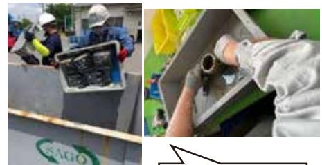
施設外作業風景
