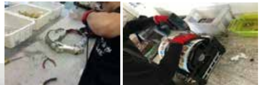
パチンコ・スロット解体
